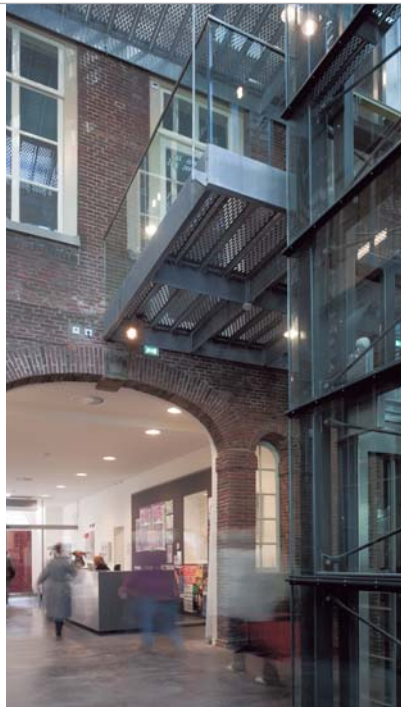
Liftschacht op de hoofdlocatie.
