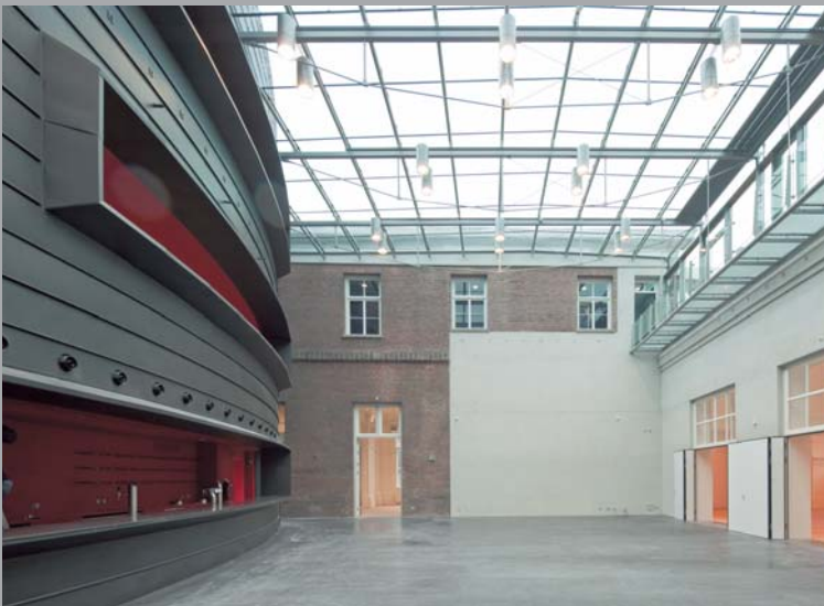
Het door Hans van Heeswijk architecten ontworpen, in samenwerking met Octatube uitontwikkeld, kozijnloze atriumdak van het hoofdgebouw.
