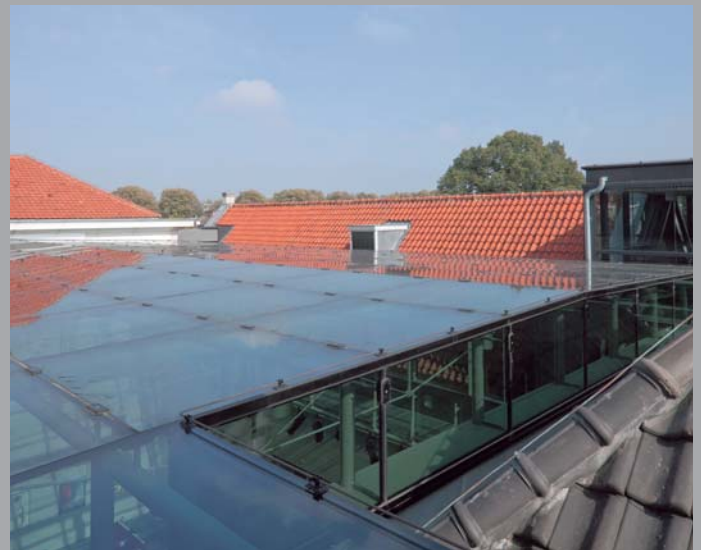
Het door Hans van Heeswijk architecten ontworpen, in samenwerking met Octatube uitontwikkeld, kozijnloze atriumdak van het hoofdgebouw.
